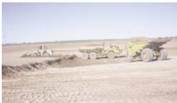
Foto 2. Retirada y acopio de tierra vegetal
