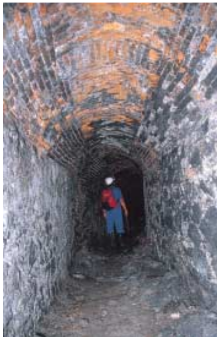
Pozo San Teodoro. Planta 1ª. Revestimiento del siglo XVIII
