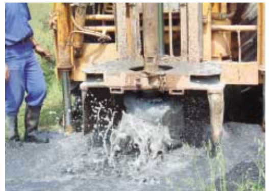
Fotografía 1: Ejecución del sondeo mecánico.
